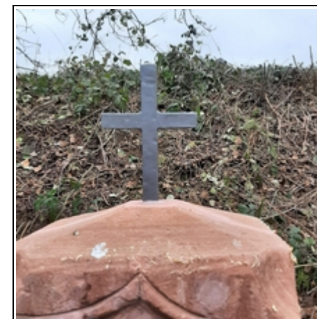
Der Riss ist beseitigt, der Sandstein überarbeitet und ein neues Kreuz wurde angebracht.
