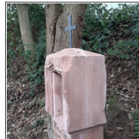
Der Riss ist beseitigt, der Sandstein überarbeitet und ein neues Kreuz wurde angebracht.
